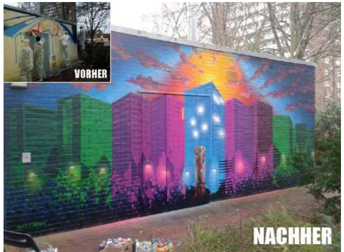
Dieses GEWOBA-Gebäude wurde im Rahmen eines kreativen Projektes mit einem Oldenburger GraffitiKünstler von Bremer Jugendlichen selbst gestaltet
